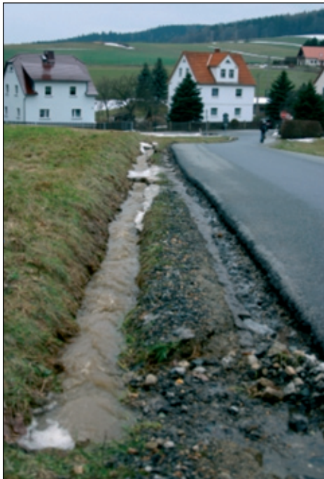
Abbildung 2.3-2 (oben): Hangrutschung während der Schneeschmelze – Böschungssystem im Rahmen des Straßenausbaus hergestellt (Schönberg, Gemeinde Cunewalde)
