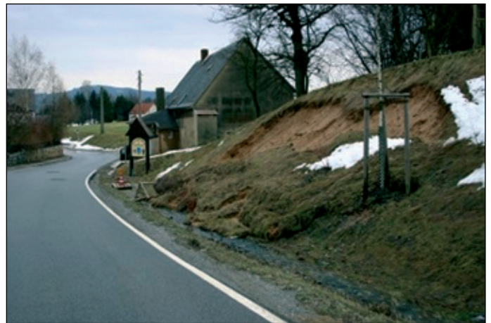
Abbildung 2.3-2 (oben): Hangrutschung während der Schneeschmelze – Böschungssystem im Rahmen des Straßenausbaus hergestellt (Schönberg, Gemeinde Cunewalde)
